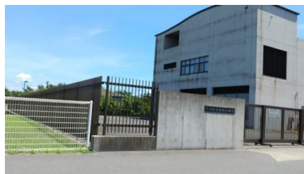
▶千葉県吾妻配水機場
